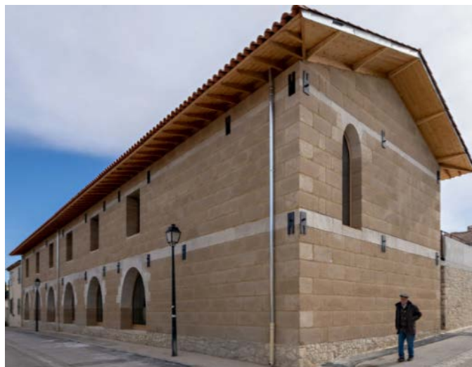
Hình 1. Trung tâm y tế tại Pháp được xây dựng bằng gạch đất nén bởi công ty Filiater
