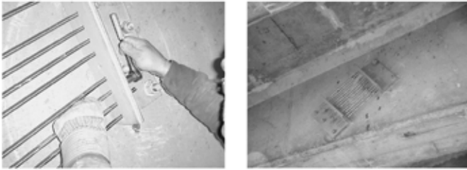
Hình 3. Sửa chữa vết nứt cho dầm cầu, mặt cắt chữ T bằng BTCT tại Michigan [10]
