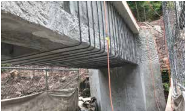
Hình 5. Gia cường cắt cho dầm cầu tại St.-Lesgier-Fenil - Thụy Sĩ
