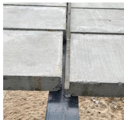
Hình 4. Dầm thép không có liên kết với bản sàn bê tông nhẹ EPS-C
