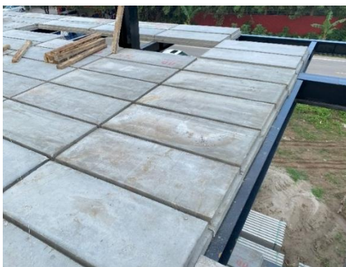
Hình 4. Dầm thép không có liên kết với bản sàn bê tông nhẹ EPS-C
