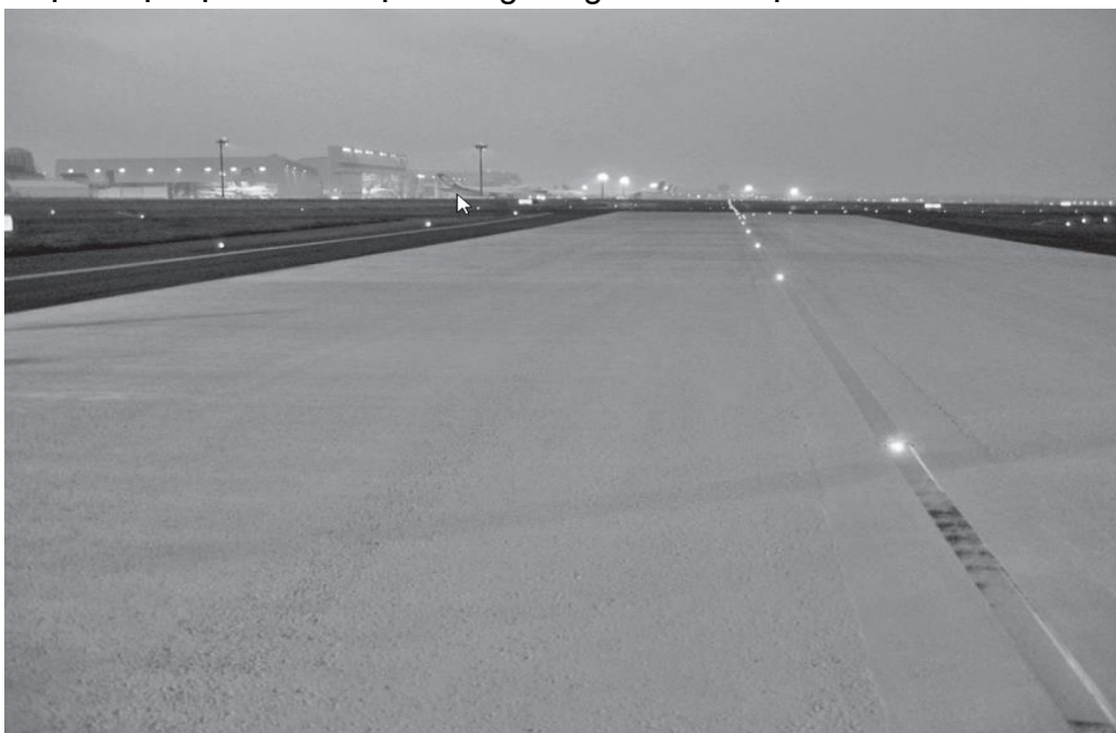
Hình 7. Ví dụ thi công tại đường lăn sân bay (Sân bay Quốc tế Narita, Nhật Bản)
